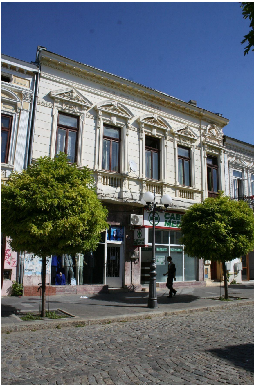
Clădirea fostului Dispensar al Comunității Evreilor din Brăila, donația Nedelcu P. Chercea, str. Mihai Eminescu.
